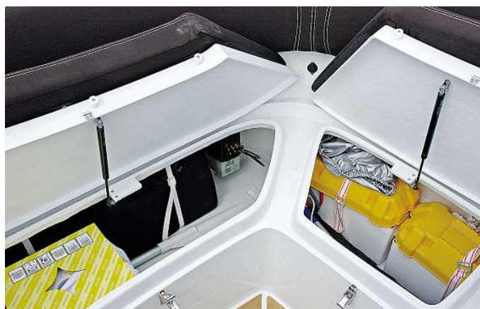
Die Batterien sind gut zugänglich unter der Seitenbank befestigt
